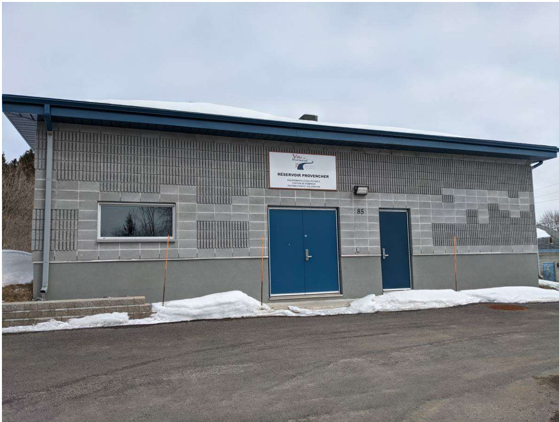
Figure 15 : Réservoir / Bâtiment de service Provencher
