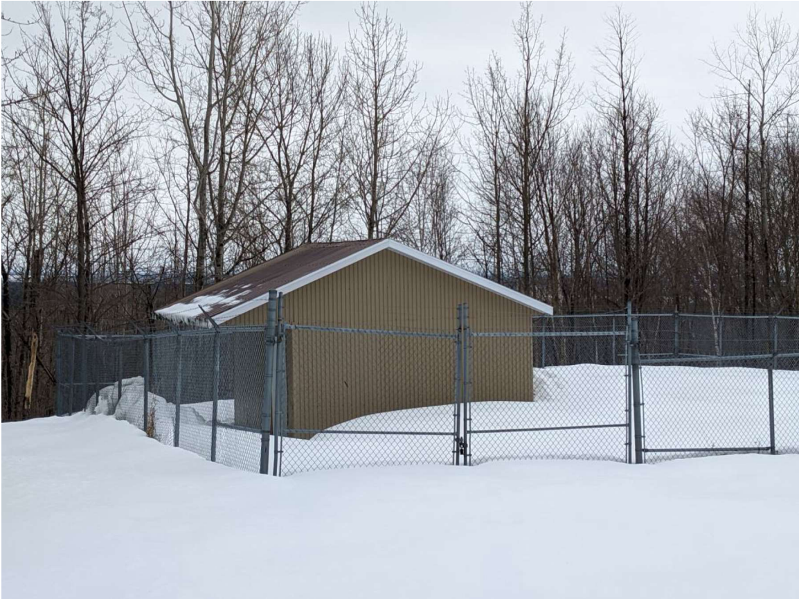
Figure 12 : Réservoir / Bâtiment de service Saint-Louis
