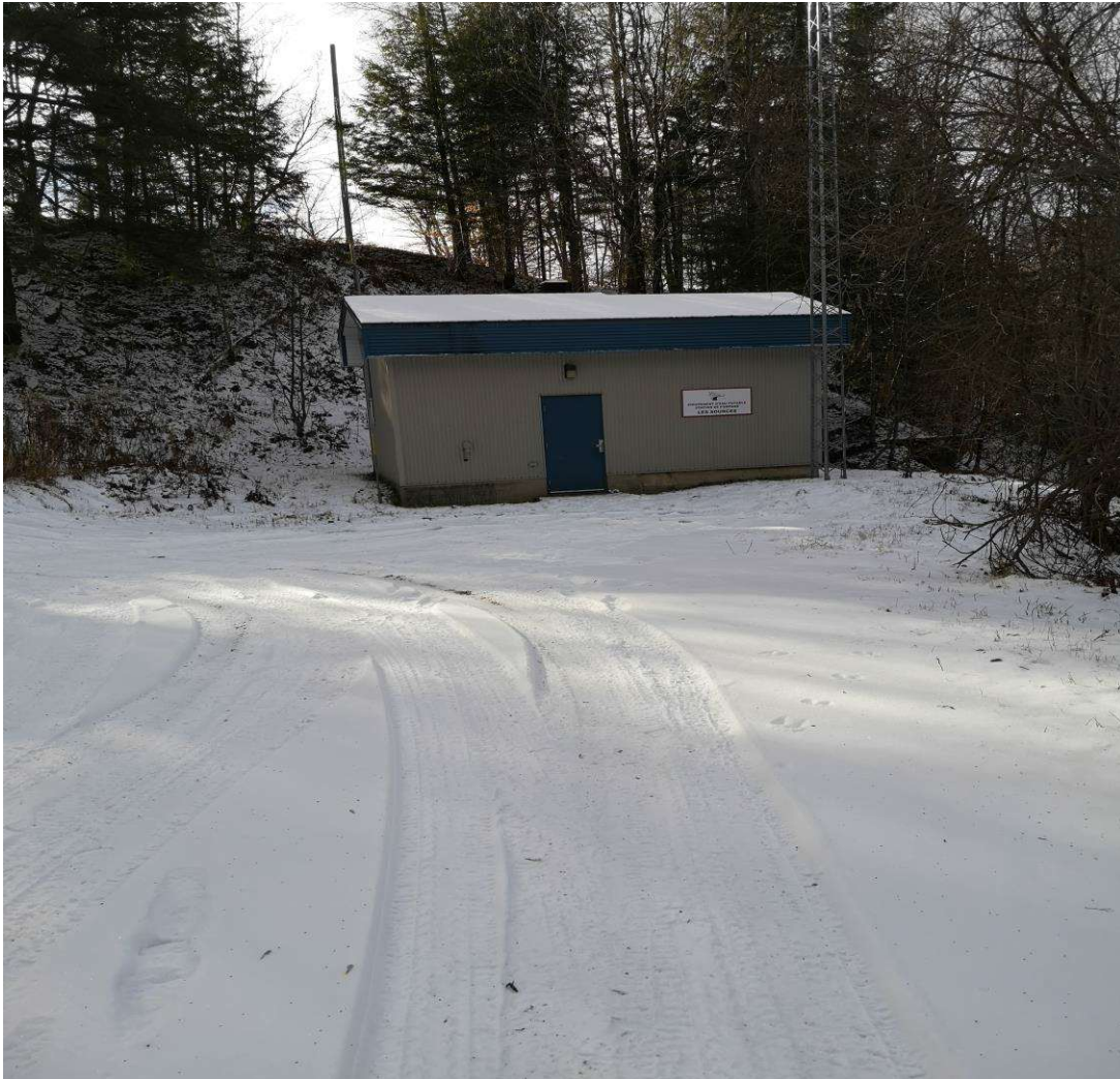
Figure 14 : Réservoir / Bâtiment de service Les Sources
