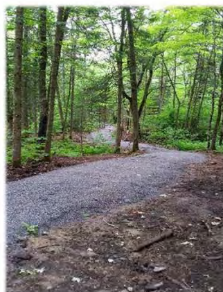
Sentier de marche aménagé dans le cadre du projet de « développement de sentiers de vélo de montagne, sentiers pédestre et d'un pumtrack » en juillet 2018.
